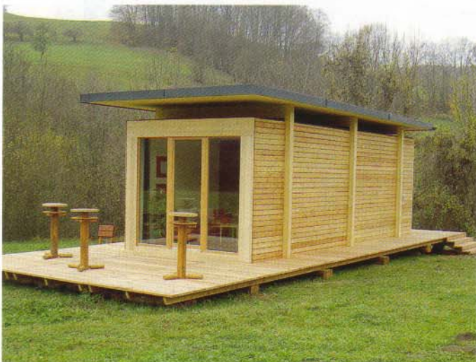
So sieht ein Modul des Microhotels aus. Es ist aus Holz in Niedrigenergie-Bauweise hergestellt, transportabel und beliebig kombinierbar.
